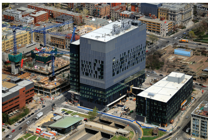
On y est presque! Les pavillons R et S sont pratiquement terminés, et la construction de l'hôpital (à gauche) est bien entamée (photo du 2 mai 2013).
