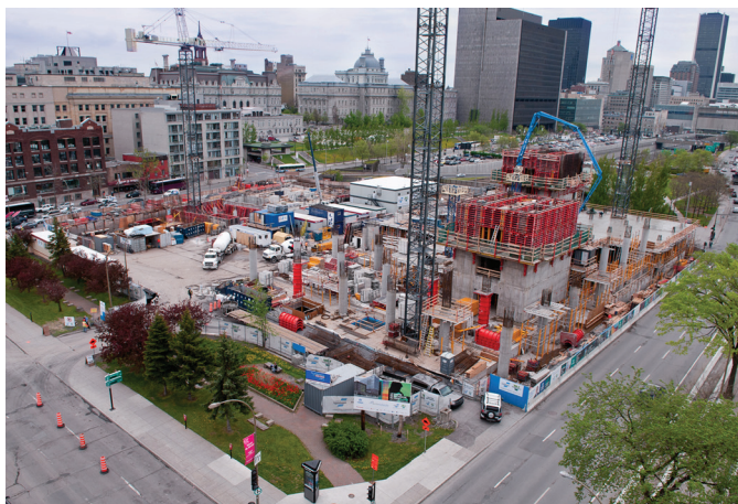
Avant de construire, il faut démolir les vieux bâtiments où se trouveront les nouveaux pavillons (photo du 18 juin 2010).
